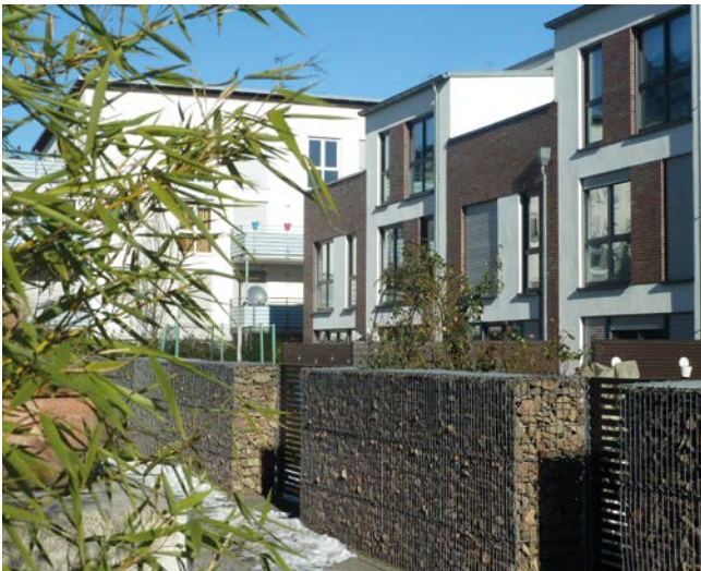
Wohnungsbau in Wiesbaden.
