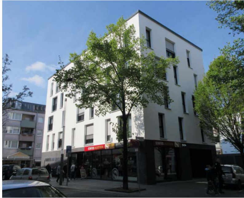
Geförderter Wohnungsbau in der Innenstadt von Gießen. Bildrechte: HA Hessen Agentur GmbH ↑
