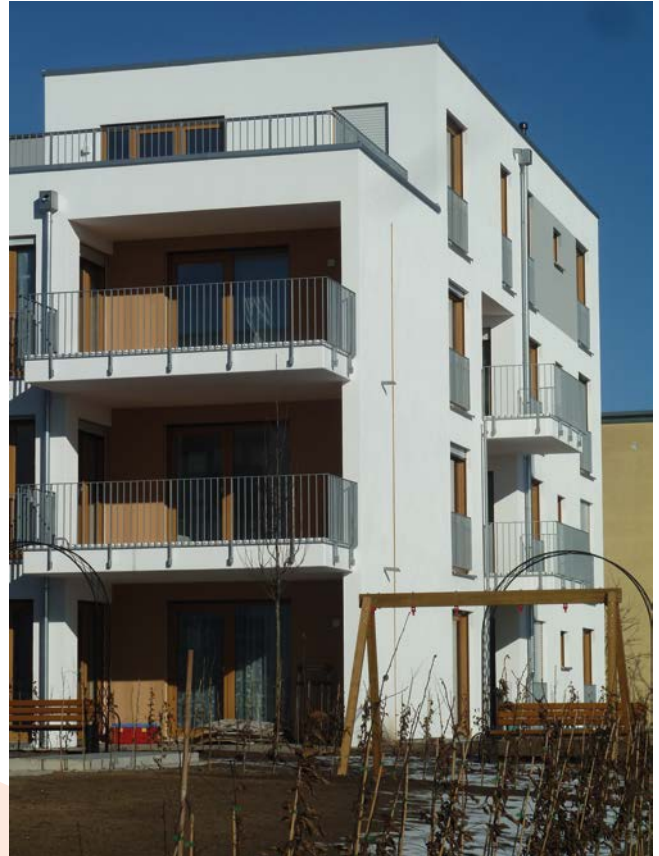
Wohnungsbau in Wiesbaden. Bildrechte: HA Hessen Agentur GmbH ↑
