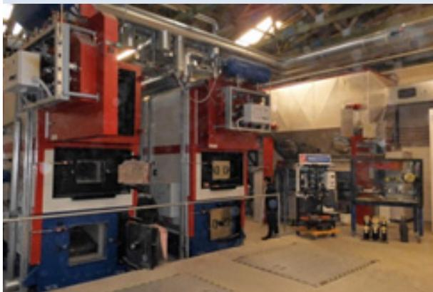
Zu sehen sind die beiden Biomassekessel sowie eine Hausübergabestation und ein Schaukasten mit Rohrteilen, die in der Straße verlegt wurden.
